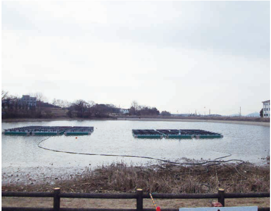
ため池のフロート式太陽光発電
